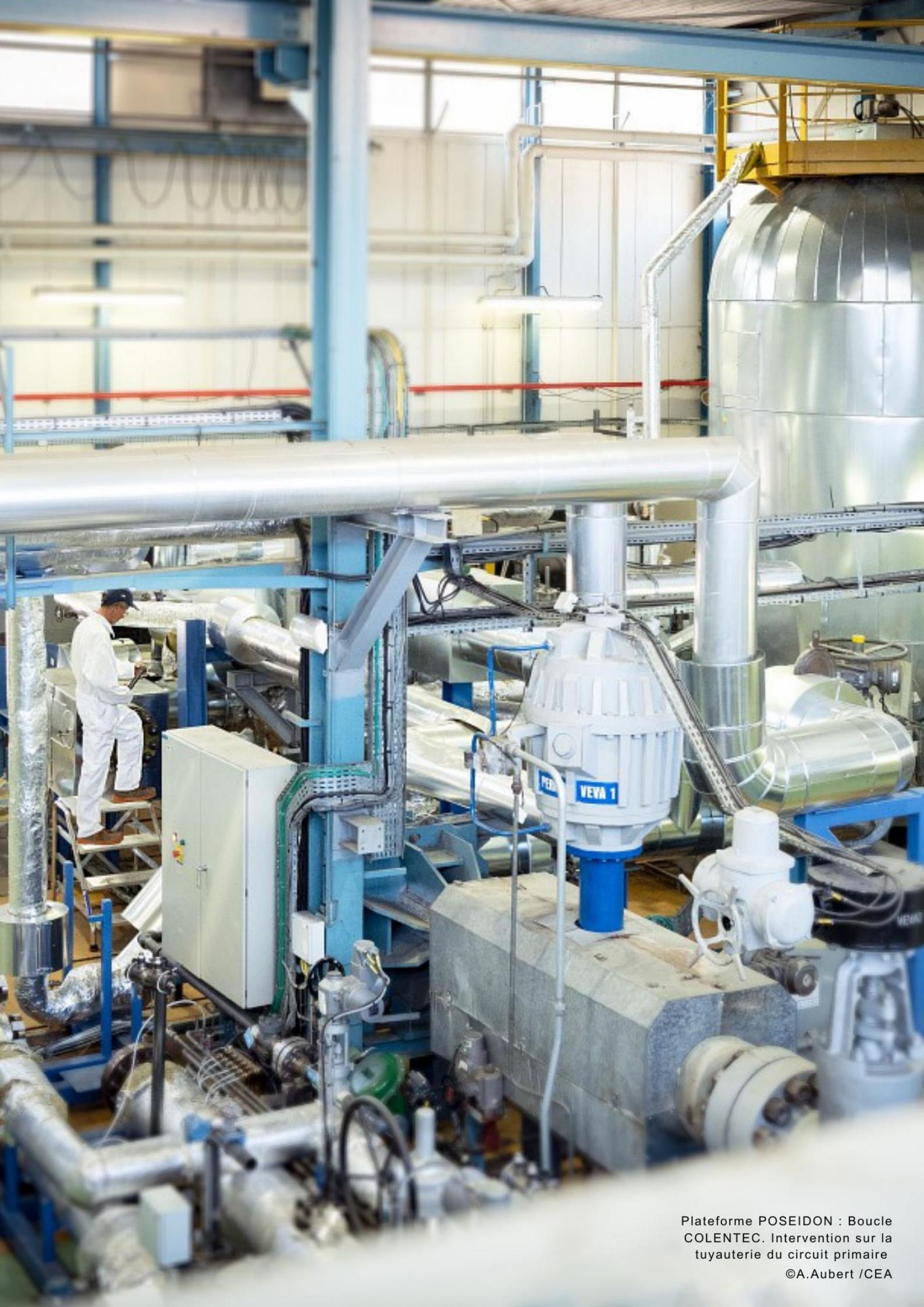
Plateforme POSEIDON : Boucle COLENTEC. Intervention sur la tuyauterie du circuit primaire
